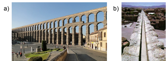
Figura 1. a) Aqüeducte de Segovia vist des de la calçada, b) vista del canal superior de l'aqüeducte.
